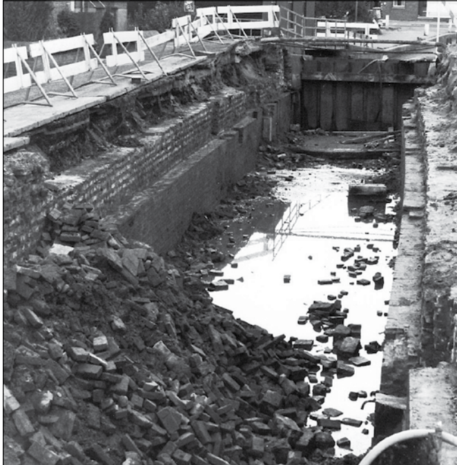
Werkzaamheden tijdens de renovatie van 1987
